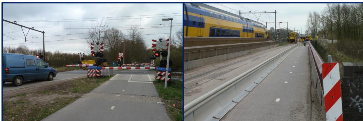
Figuur 4.9: Spoorwegovergang (links) en smalle doorgang op het viaduct (rechts) op de fietsroute Utrecht Lunetten – De Uithof.
